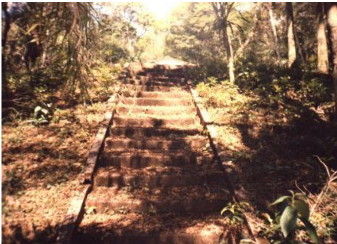
escada que leva da piscina até a casa branca, onde se pretende fazer um centro de visitantes.
